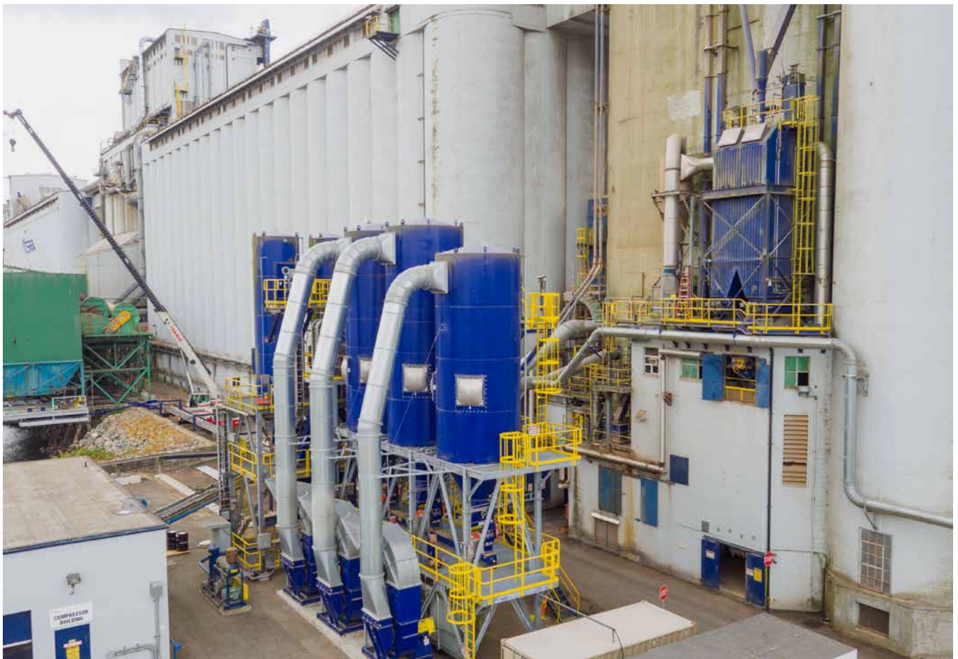
Abbildung 1: Die Pacific- und Cascadia-Terminals von Vittera verarbeiten verschiedene Getreideprodukte, wobei viel Staub entsteht, der entfernt und gefiltert werden muss.
