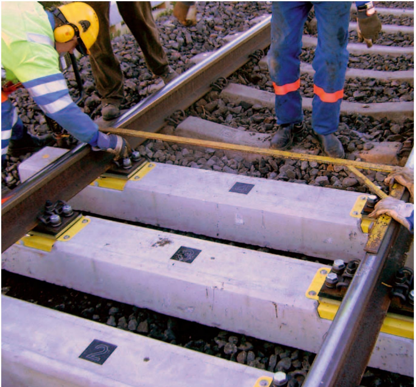
Bild 3: In der Höhe unterscheidet sich die Wägeschwelle nur minimal von den Standardschwellen und fügt sich nahtlos in die Strecke ein. Fig 3: The height of the sleeper only differs very slightly from that of standard sleepers and it fits seamlessly into the track.
