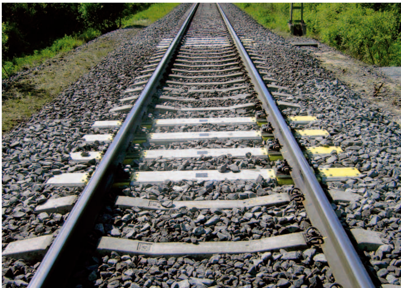
Bild 1: Die Anordnung der Schwellen trägt dem Einfluss der verschiedenen Schwingungsformen bei fahrenden Zugverbänden Rechnung. Fig. 1: The arrangement of the sleepers takes into account the various vibration forms of driving train sets.
